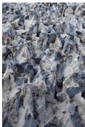
(c)露出粗骨料的基层表面（侧视图）
