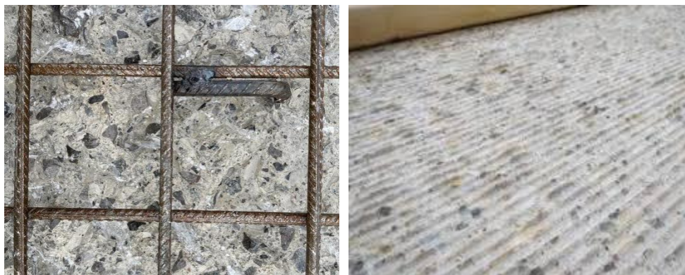
(a)露出粗骨料的基层表面（俯视图）
