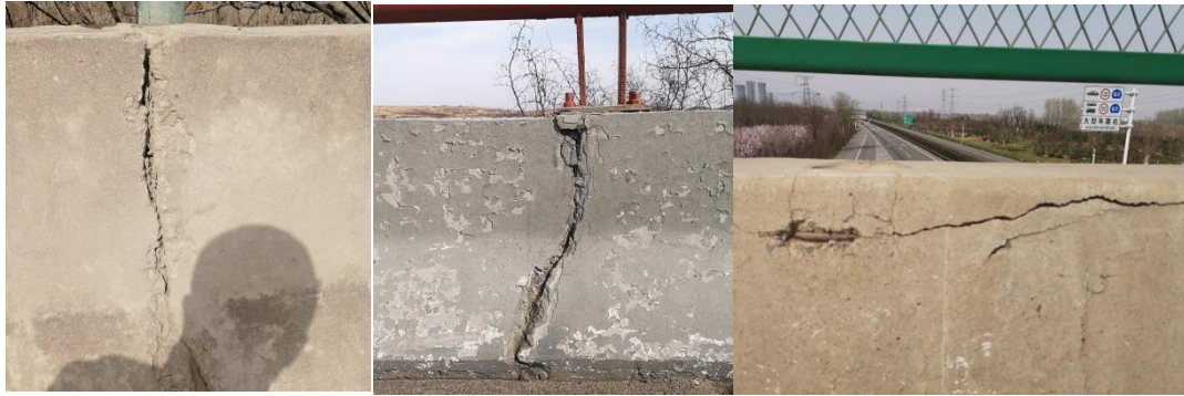
图 5.1.2-5 混凝土护栏裂缝
