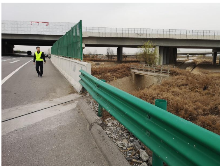
图 5.1.4-2 护栏过渡段设置不合理
