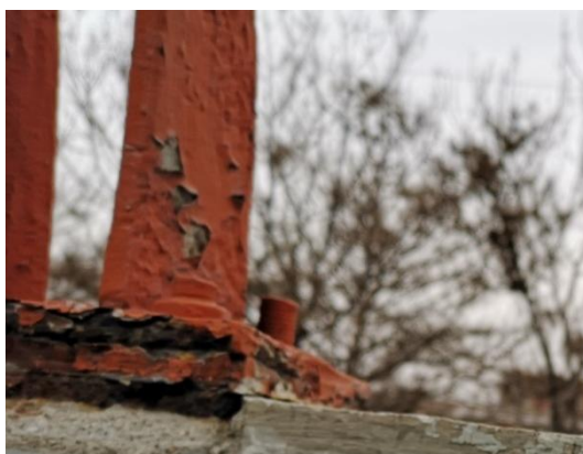
图 5.1.6-1 护栏上部钢构件锈蚀
