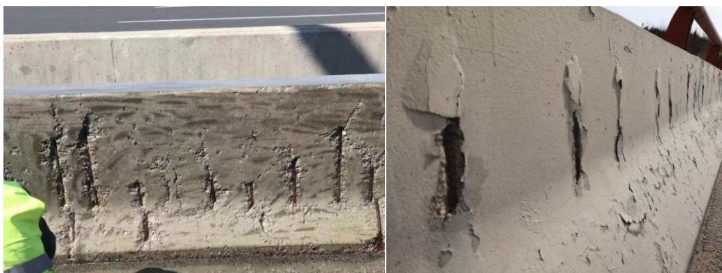
图 5.1.2-3 混凝土护栏钢筋锈胀
