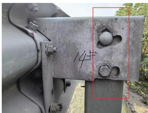
图 4.1.2-6 构件焊接或切割
