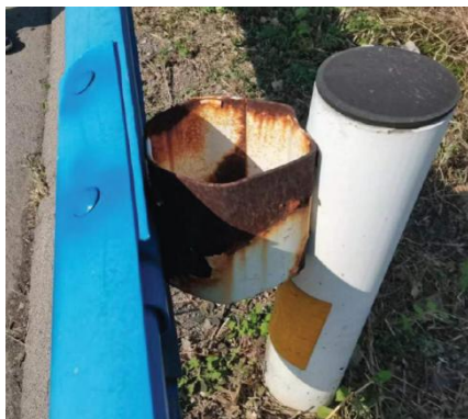
图 4.1.9-1 表面锈蚀
