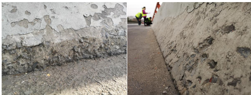
图 5.1.2-1 混凝土剥落、孔洞
