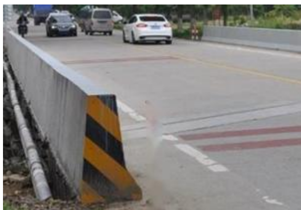
图 5.1.5-1 护栏端头设置警示设施（低等级公路）
