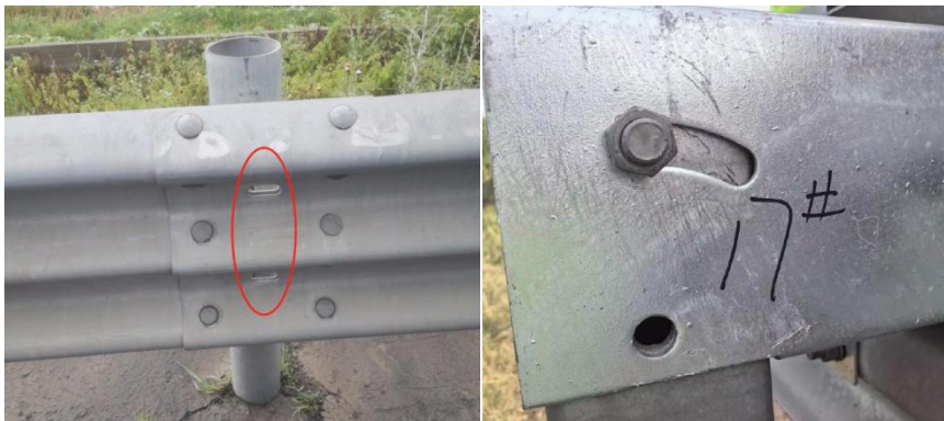
图 4.1.2-4 螺栓缺损
