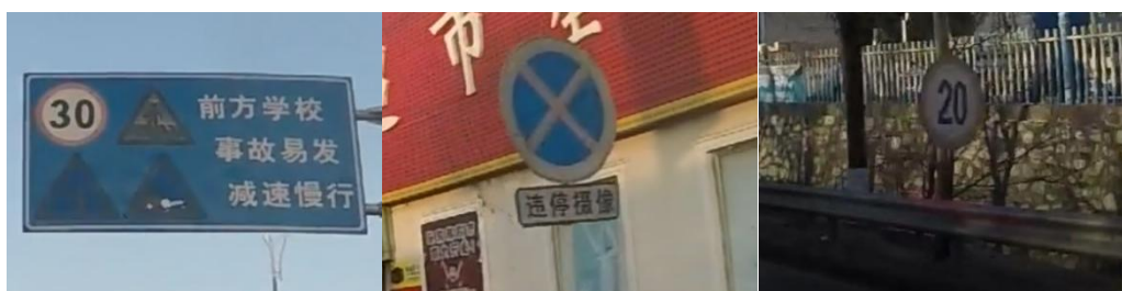
图 6.2.4-1 交通标志板面老化
