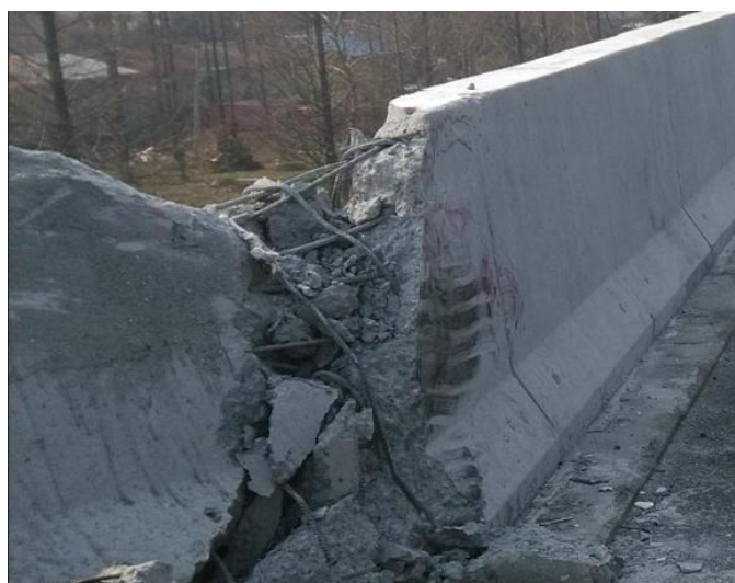
图 5.1.2-2 混凝土护栏结构破坏
