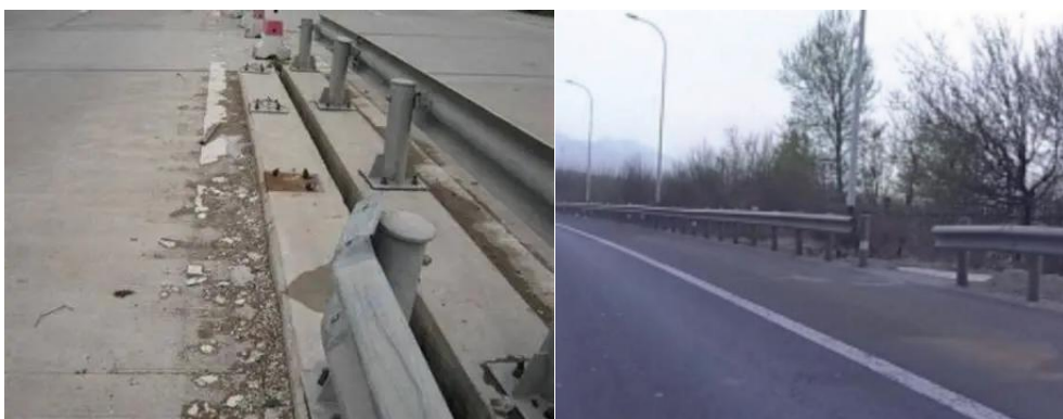
图 4.1.2-1 护栏板缺损
