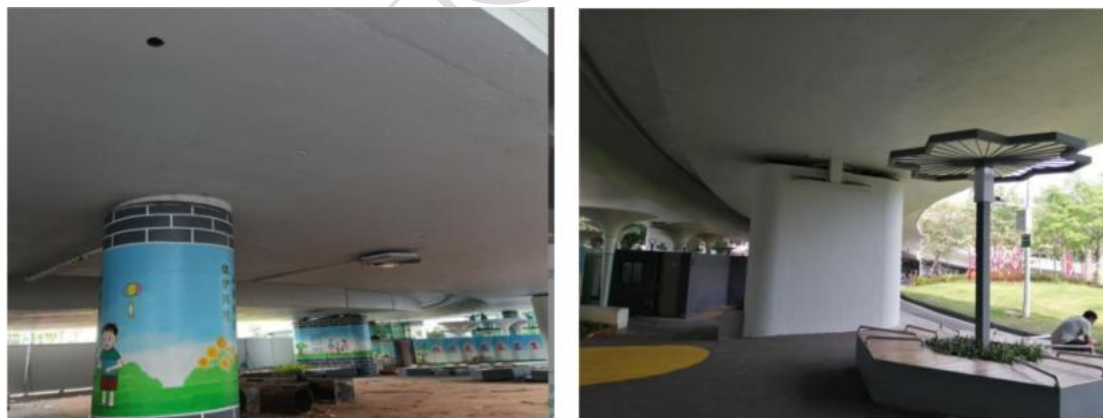
图 B.26 独柱墩桥梁
