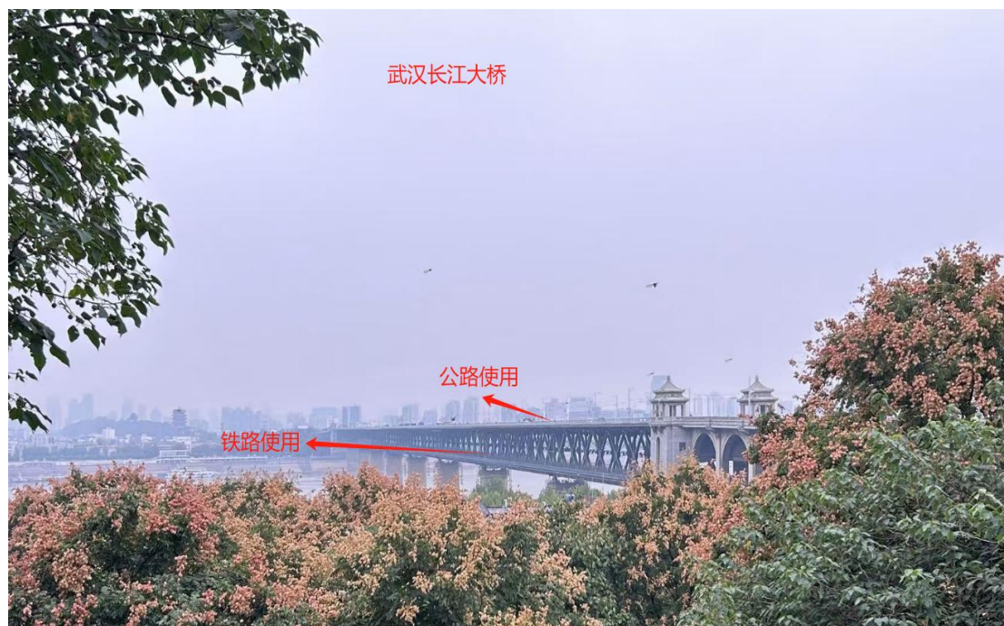
图 B.40 公铁两用桥梁
