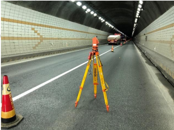
图 E.3.3-3 隧道激光断面仪检查
