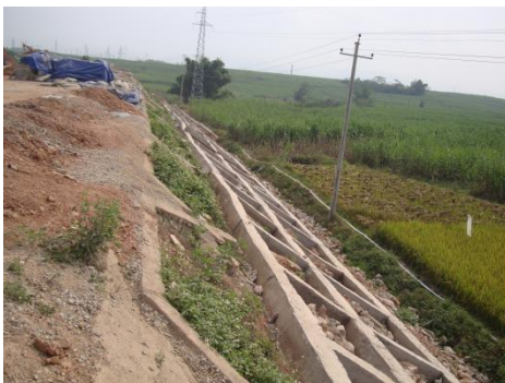
图 4.3.4 微型灌注桩桩顶与混凝土格子梁连接现场实景
