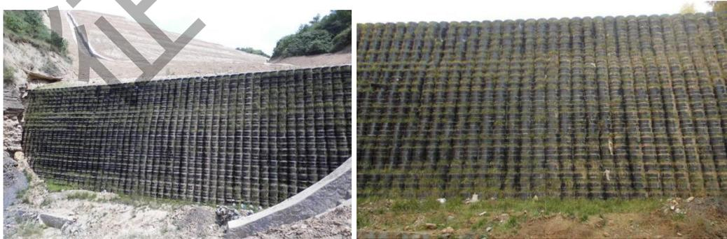
图 5 格室挡墙照片
