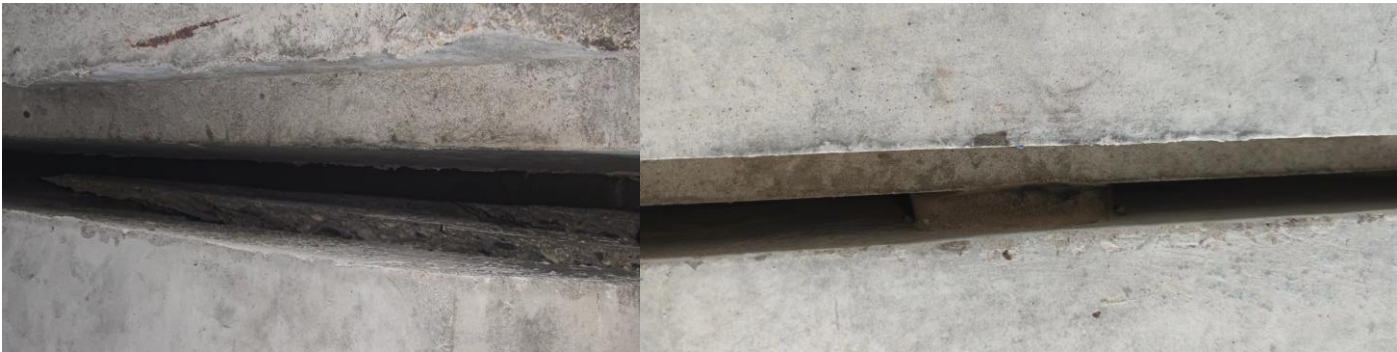
(a) 局部应力过大挤压碎裂
