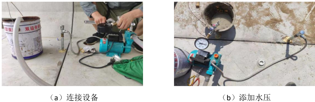
附图 C.3 箱涵接缝现场压防水试验过程示例
