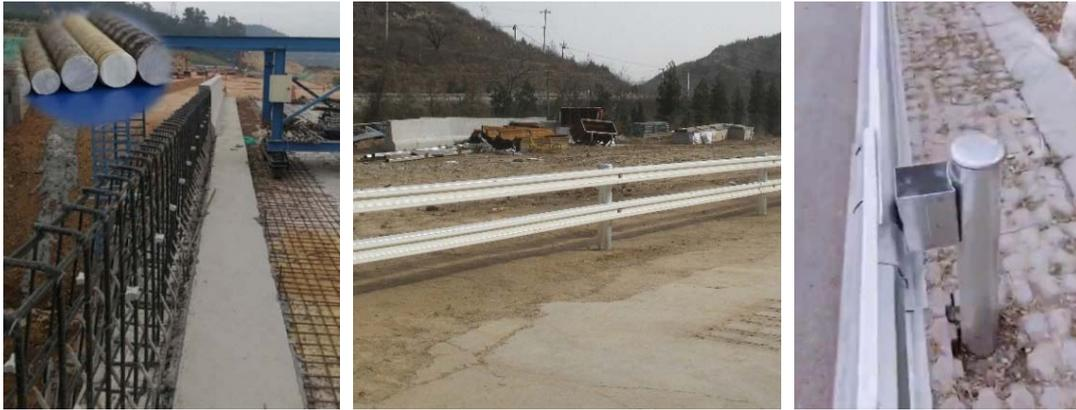
b) 玻璃纤维筋新型混凝土护栏
