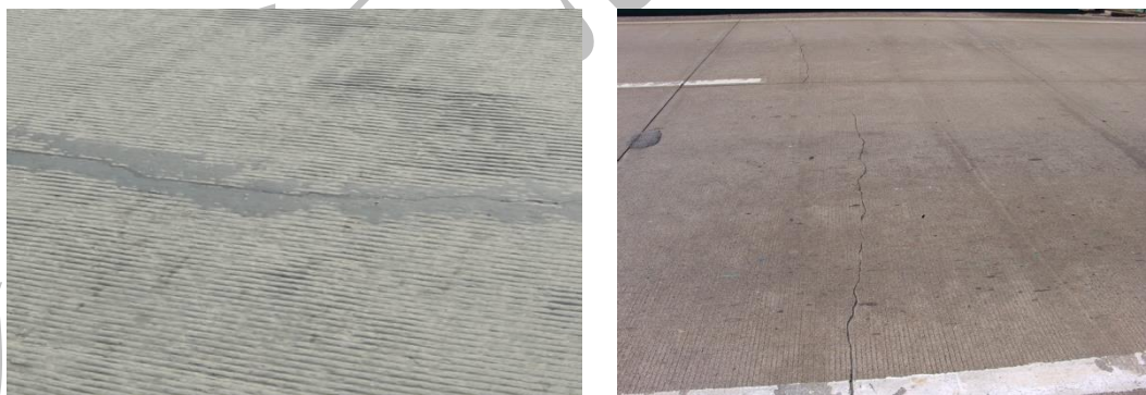
图 5.3.2 裂缝
